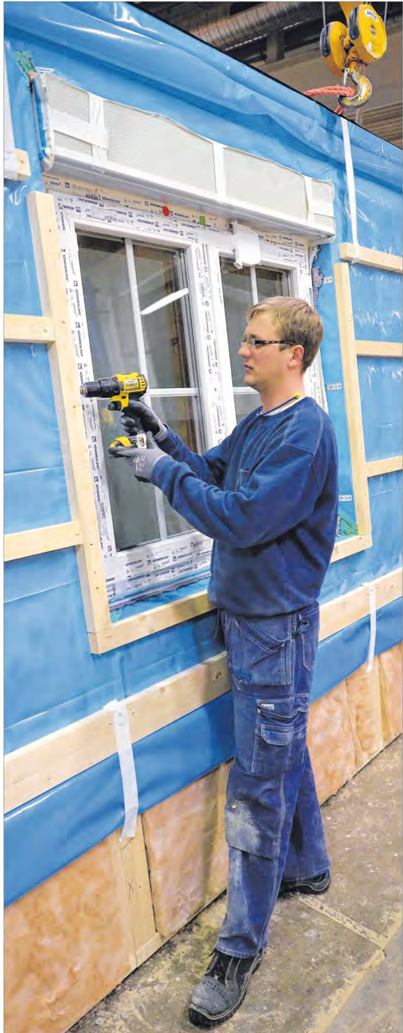
Rene Zinn (33) baut bei Scanhaus Marlow Fenster in die Wand eines Fertighauses. 600 Häuser entstehen so jährlich.
