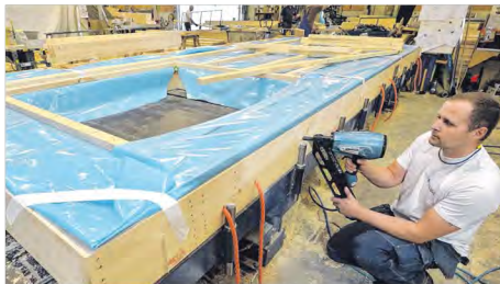
Blick in die Produktion von Scanhaus Marlow: Hier im Bild Markus Döbler (34) bei Montagearbeiten. Fotos: Frank Söllner
