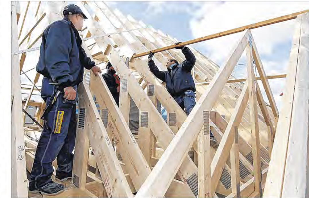
Scanhaus-Mitarbeiter montieren den Dachstuhl eines Einfamilienhauses in Sassnitz. Foto: Jens Koehler/ddp
