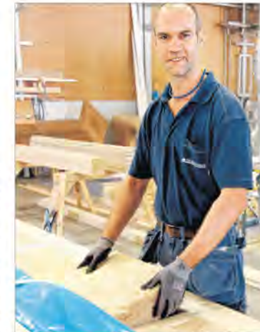
Zimmermann Daniel Mundt (41) beim Dämmen einer Außenwand.
