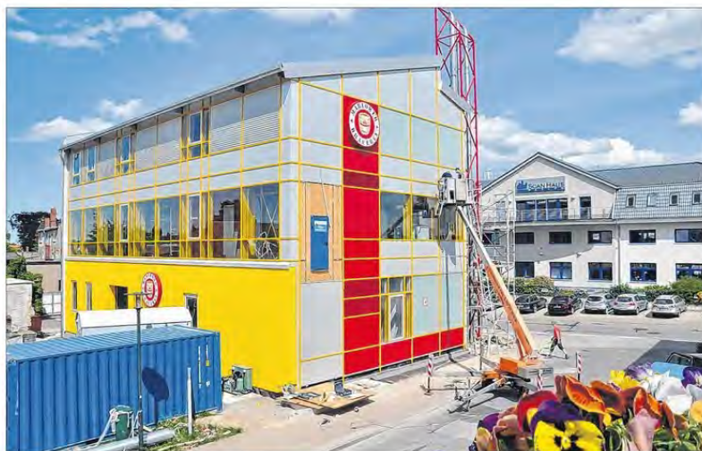
Beim Bau der Brauerei wurde viel Glas verwendet, um nach außen hin für Transparenz zu sorgen.
