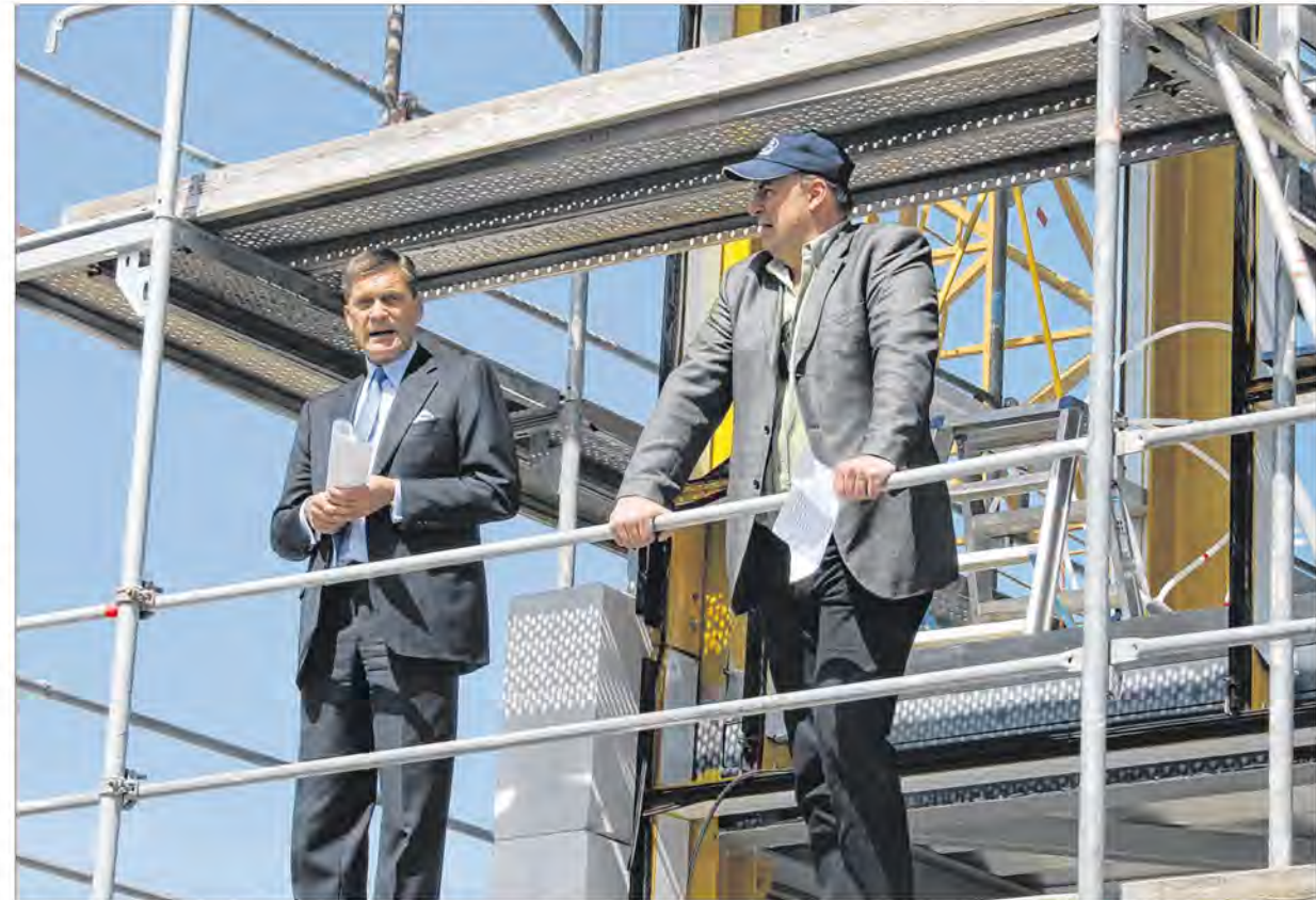
Friedemann Kunz (li.) hofft, dass das erste Bier aus der neuen Brauerei im Juli in die Fässer abgefüllt werden kann. Gilbert Brusch von der Stahl-Bau Ribnitz GmbH übernahm den Richtspruch. Foto: Edwin Sternkiker
