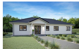
Fertighaus Bungalow SH 136 WB - Var. D2 Hauseingang
